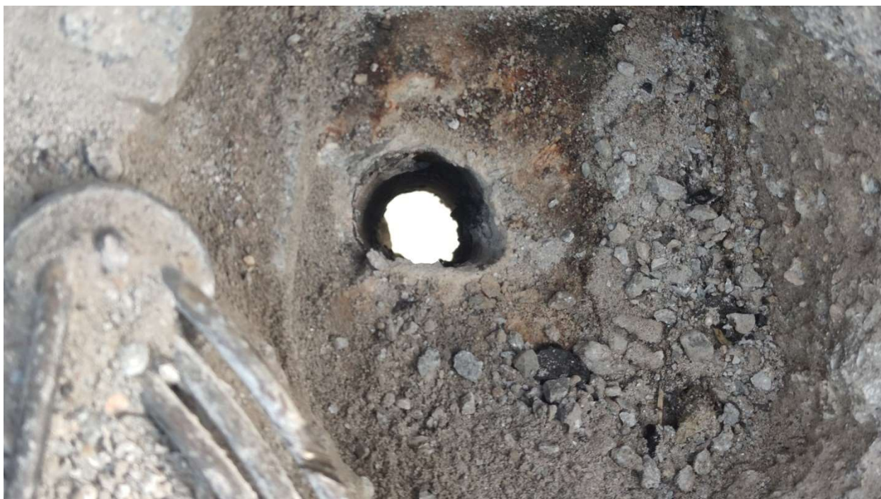
Фотографија 2.33. Горња површина кровне конструкције у зони сидрења затега – оса 8, након вађења котве 8-лево (2.11.2024.)
