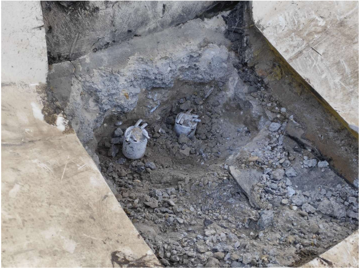
Фотографија 2.16. Горња површина кровне конструкције у зони сидрења затега – оса 2, током вађења котви (8.11.2024.)
