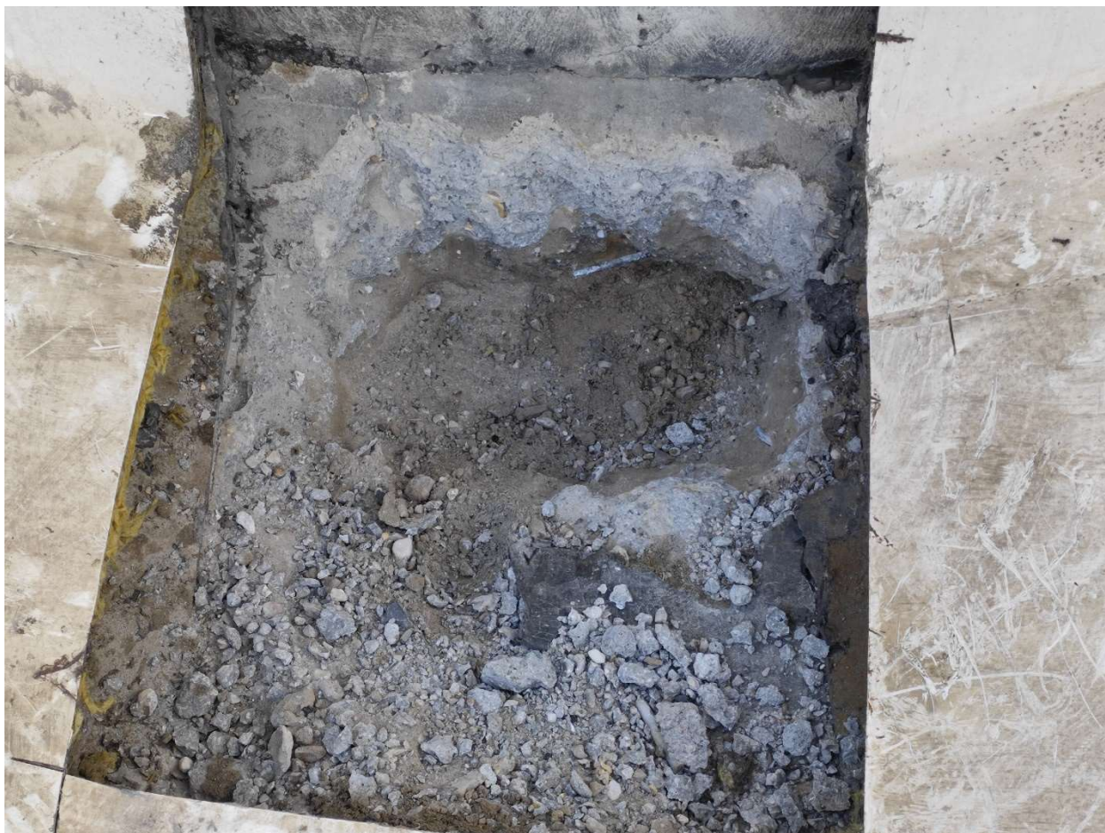
Фотографија 2.17. Горња површина кровне конструкције у зони сидрења затега – оса 2, након вађења котви (8.11.2024.)
