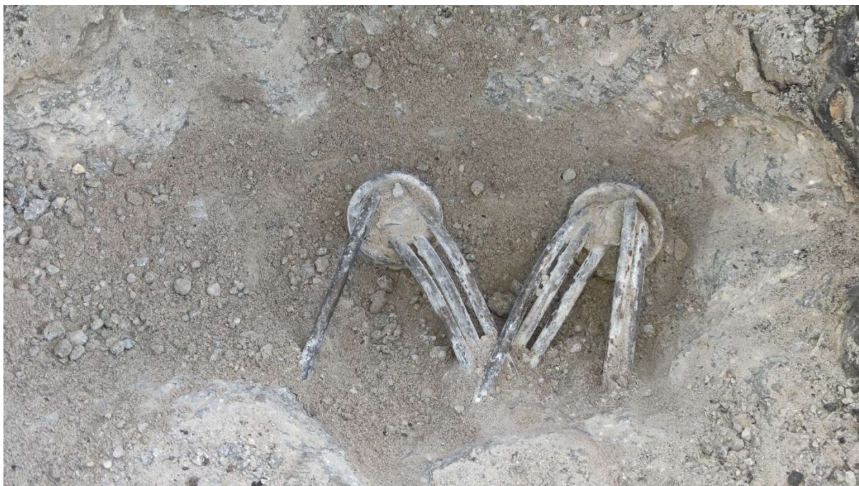
Фотографија 2.32. Горња површина кровне конструкције у зони сидрења затега – оса 8, током вађења котви (2.11.2024.)
