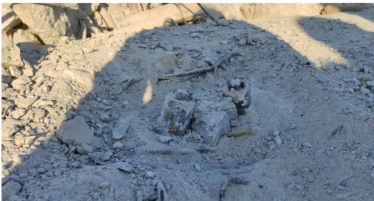
Фотографија 2.37. Котве са доње стране армиранобетонске греде надстрешнице, приликом штемања бетона – греда А (5.11.2024.)
