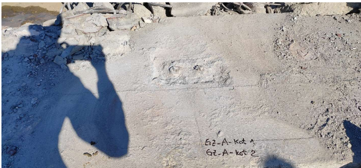
Фотографија 2.36. Котве са доње стране армиранобетонске греде надстрешнице – греда А (5.11.2024.)
