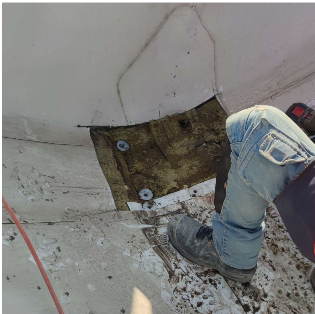
Фотографија 2.30. Горња површина кровне конструкције у зони сидрења затега – оса 8, приликом уклањања првог слоја хидроизолације (2.11.2024.)
