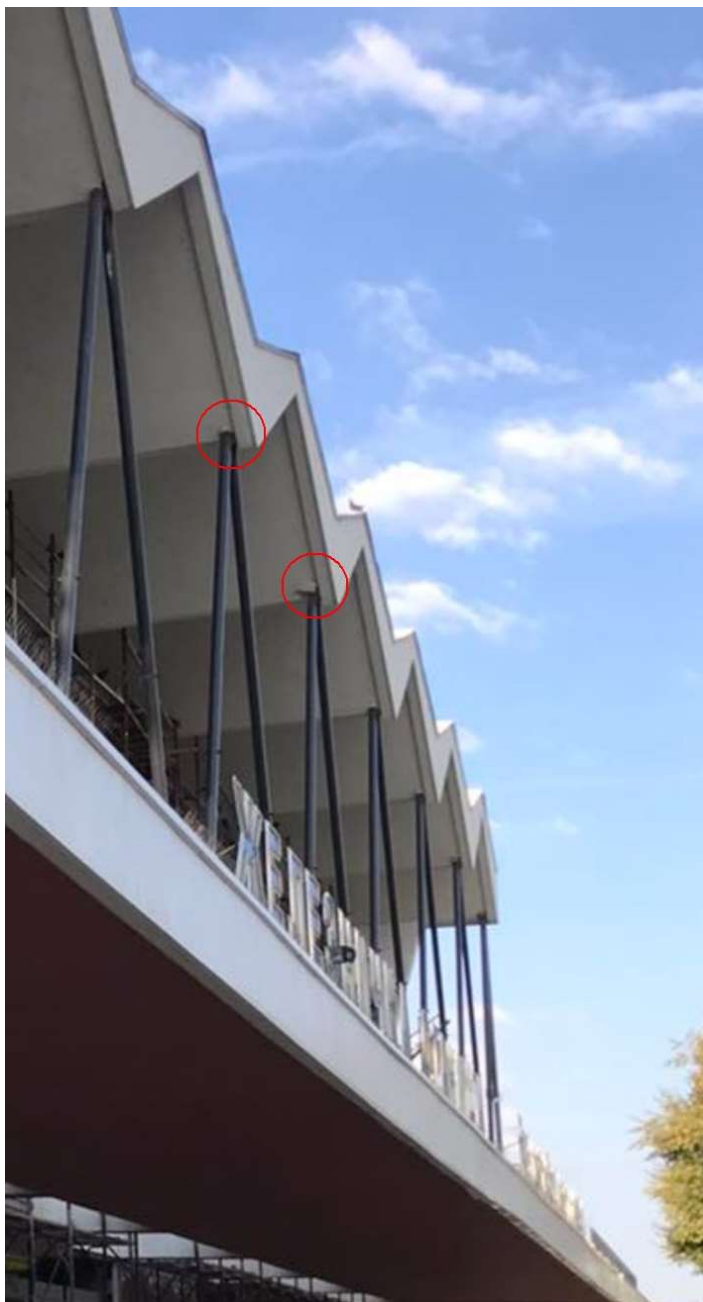
Фотографија 2.53. Оштећење облоге споја затеге и кровног носача, у току извођења радова
