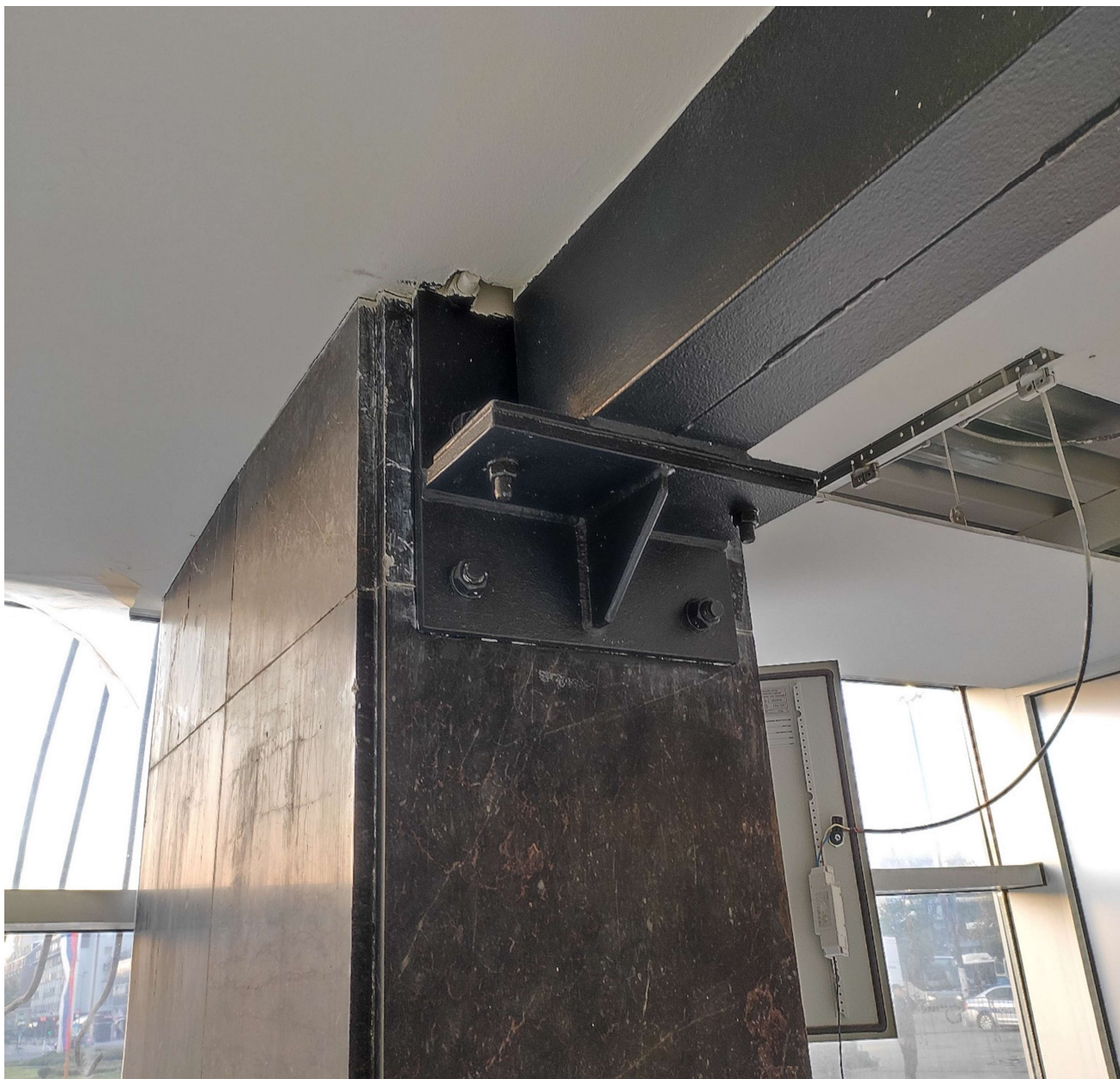
Фотографија 2.50. Ослањање попречне греде платформе на фасадни стуб (2.11.2024.)
