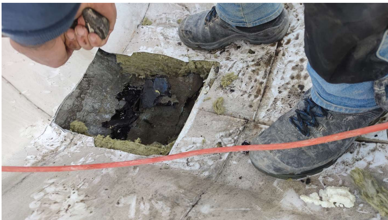
Фотографија 2.23. Горња површина кровне конструкције у зони сидрења затега – оса 7, приликом уклањања хидро и термоизолације (2.11.2024.)
