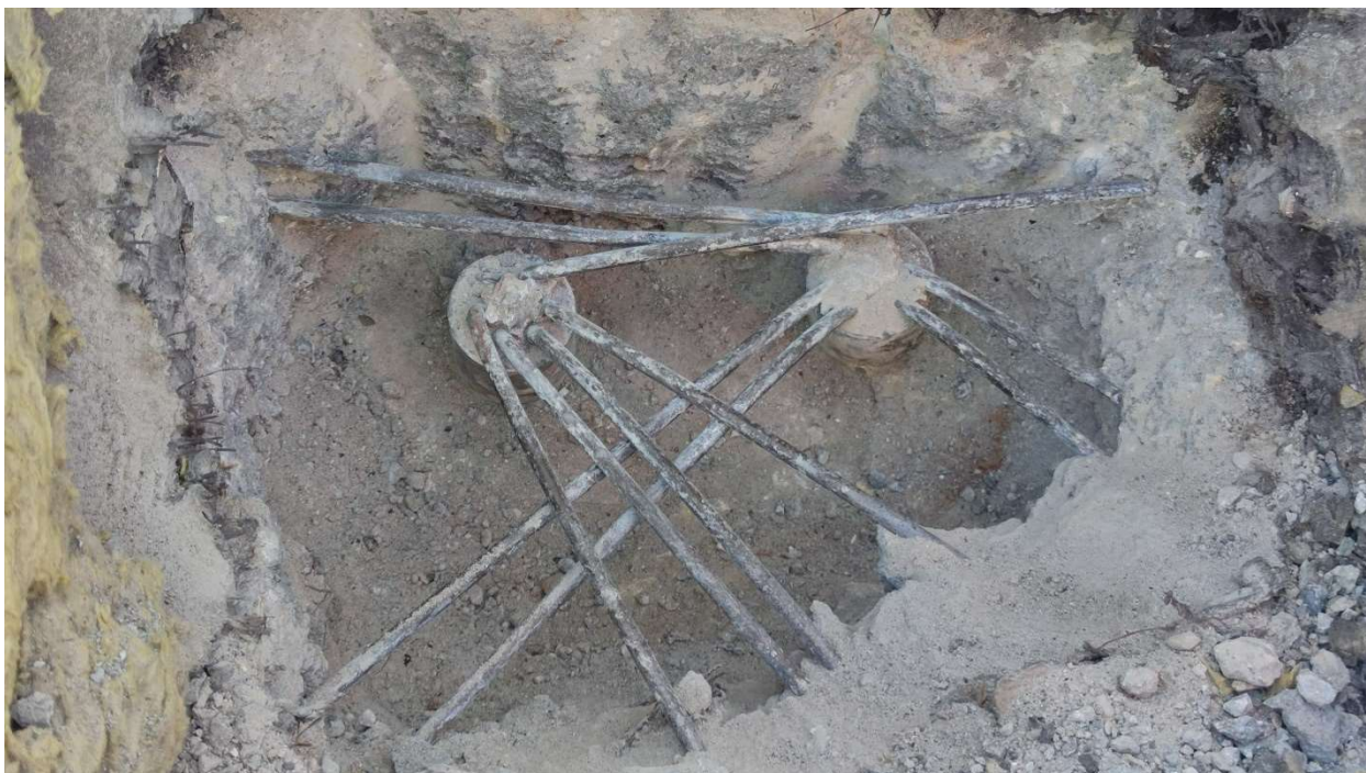
Фотографија 2.24. Горња површина кровне конструкције у зони сидрења затега – оса 7, током вађења котви (2.11.2024.)
